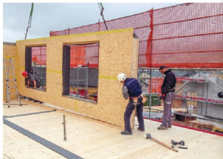
Rund 100 Tonnen Konstruktionsholz sind in diesem Haus mit vier Wohnungen verbaut.
